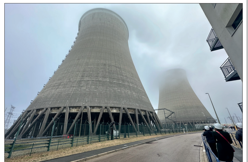
Au pied du réacteur de la centrale de Nogent.
