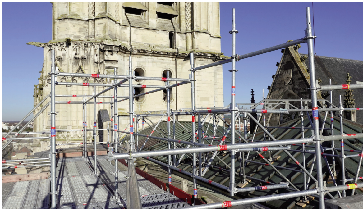
L'imposant échafaudage permet de découvrir les détails de la façade de la cathédrale de Troyes sur quinze niveaux.
