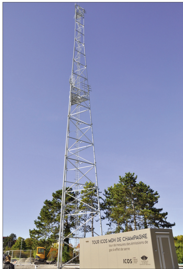
Avec ses 50 m de haut, la tour ICOS du Moulin de la Housse, à Reims, est un des fleurons du dispositif européen de suivi des émissions de gaz à effet de serre. En France, il n'existe que 4 tours dont la hauteur est supérieure ou égale à 50 m.
