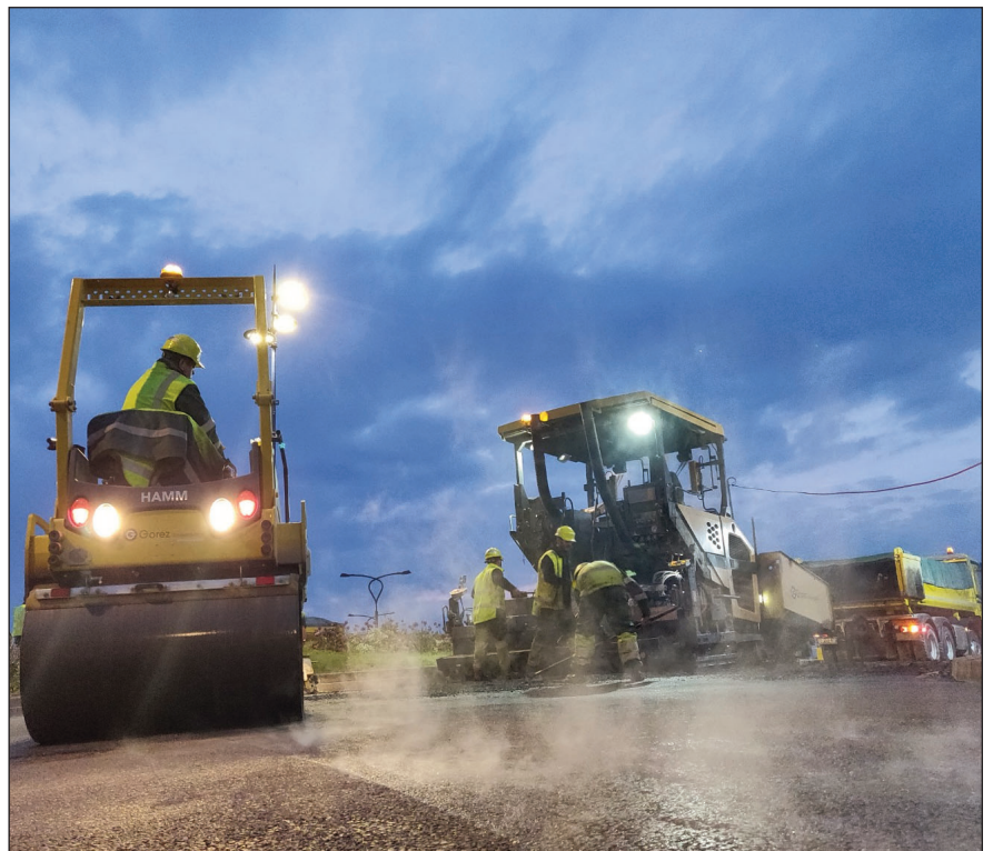
Les engins de chantier de Gorez Travaux publics ont été équipés de signaux sonores moins stridents, à 75 db, pour éviter les nuisances tout en conservant la sécurité.
