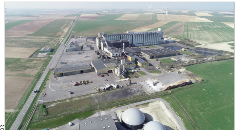
Le site de Pauvres de Luzéal termine le processus de transformation de la luzerne par la déshydratation en broyant, défibrant et chauffant le produit.
