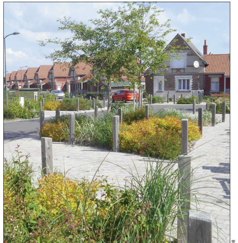
Les travaux de requalification ont duré de 2013 à 2018.
