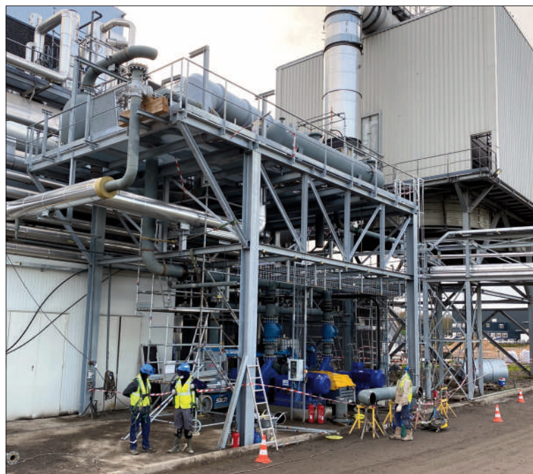
Friedlander a effectué un chantier de production vapeur en Picardie.
