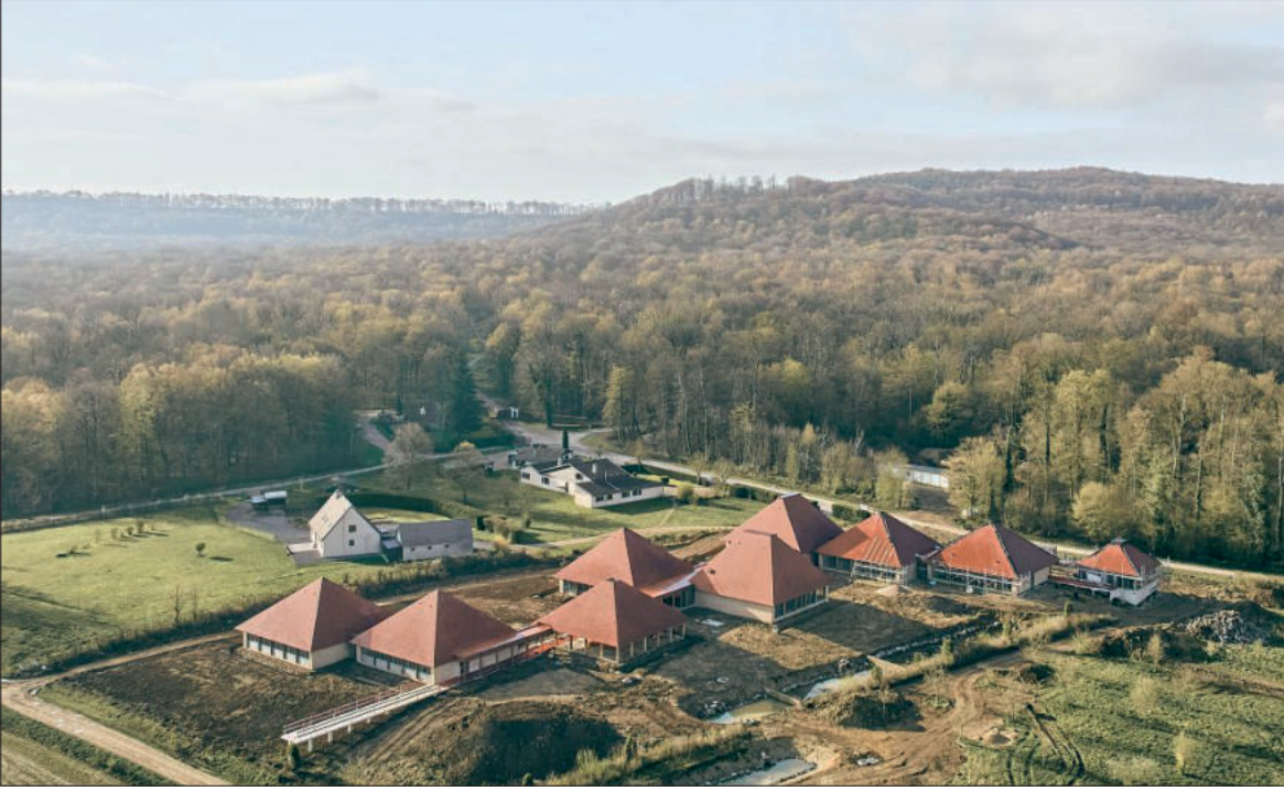
Lancé en 2024, le chantier a fait sortir de terre un véritable hameau d’une surface totale de 2 500 m², avec 9 pavillons.
