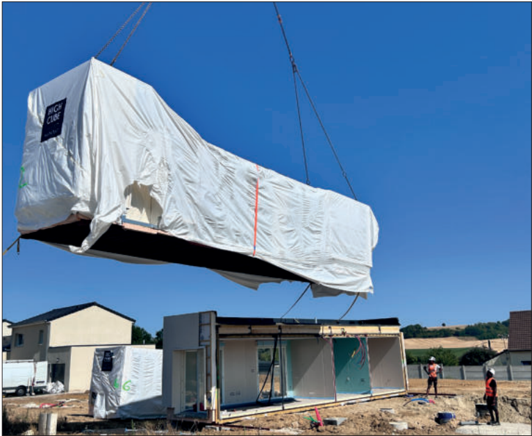
Une maison de 110 m 2 nécessite l'empilement de cinq conteneurs de tailles différentes.
