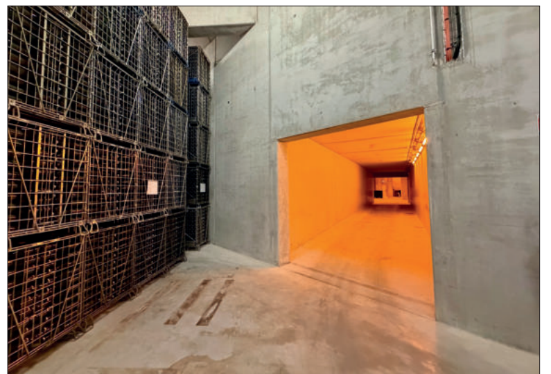
La nouvelle cave enterrée et tempérée.
