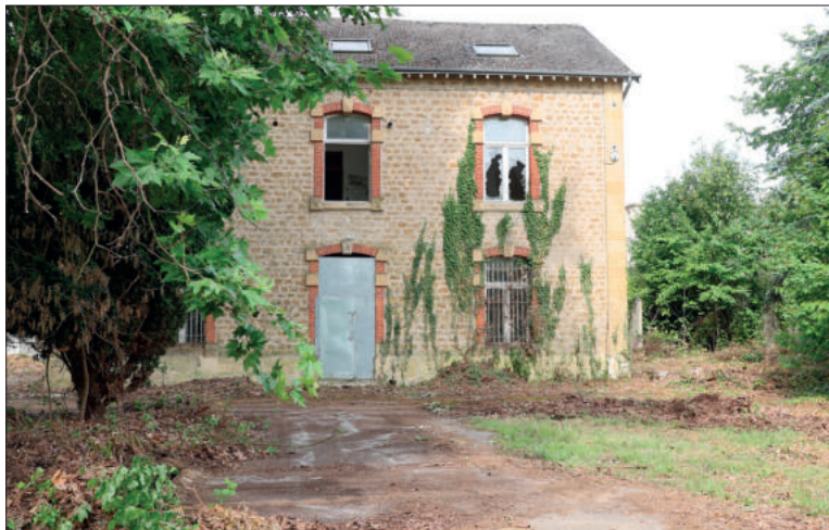
La future infrastructure sera implantée rue Mirbritz, sur le site de l'ancienne caserne Macdonald.
