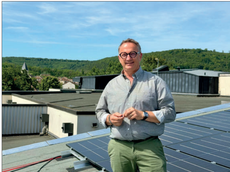
Olivier Martin sur le toit du bâtiment équipé en panneaux photovoltaïques.
