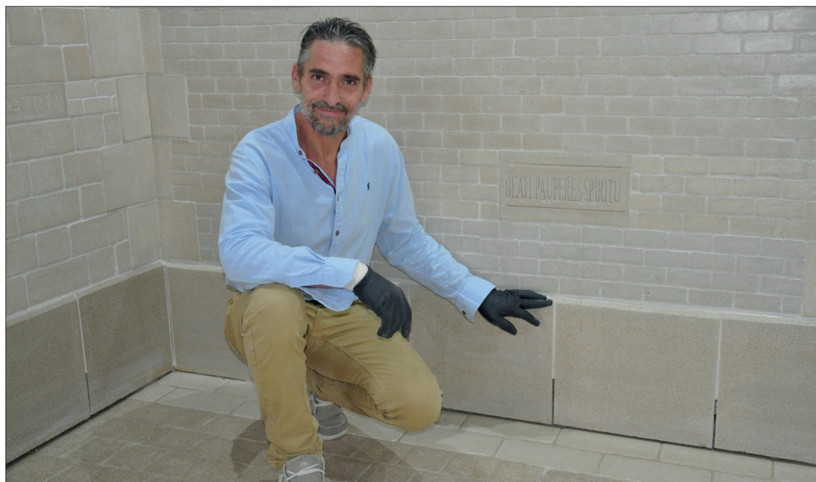
Dans son showroom, Jérôme Brodier montre le soubassement complexe sur lequel s'appuient les panneaux motifs, élégant habillage d'une Isolation Thermique Extérieure.
