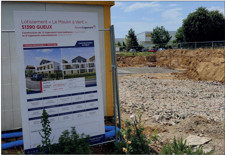
À Gueux Plurial Novilia engage 2,7 M€ pour la construction de 18 logements.
