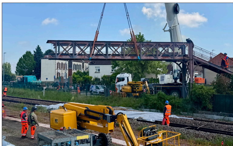
Chaque partie de la passerelle a été levée et directement posée sur des camions en attente de chaque côté des voies avant d'être évacuée.
