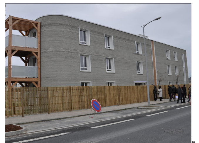
L'immeuble ViliaSprint2, construit en 3D béton.
