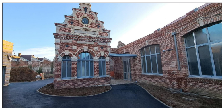
Ce chantier illustre la montée en puissance d'une entreprise qui, depuis sa création en 2006 par Christophe Quennesson, est passée d'une structure artisanale à une société de plus de trente salariés qualifiés.
