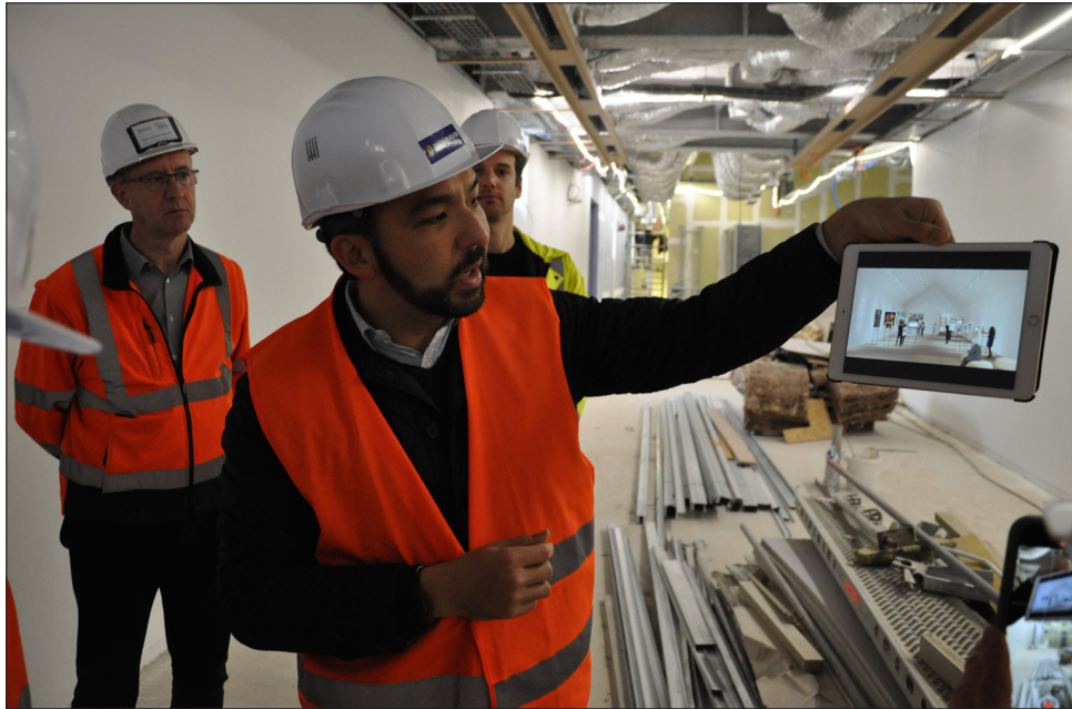
Dans un bâtiment toujours en travaux, Georges Magnier, directeur des musées de la ville de Reims, présente la vue d'une salle telle que la découvriront les visiteurs.
