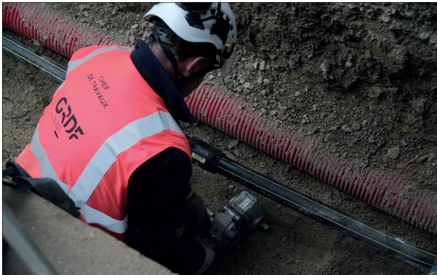
Des canalisations pour le réseau de gaz troyen en matériau biosourcé.
