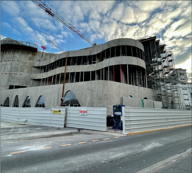
Le bâtiment de l'Esad, sous la houlette de l'architecte Jean-Pierre Lott, commence à prendre forme, tout en courbes et en arches monumentales.
