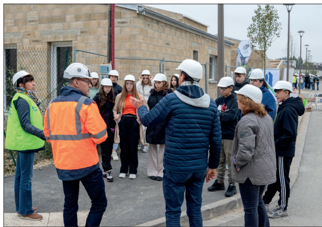
Les élèves ont pu profiter de la visite et des explications sur cet important chantier.
