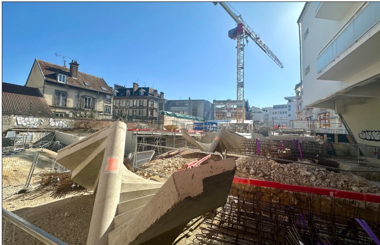
Relancer la construction de logements et le parcours résidentiel des citoyens comme ici avec le chantier du quartier gare à Troyes réalisé par Mon Logis.
