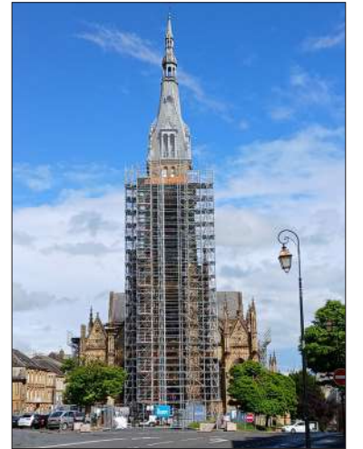
Ce chantier a nécessité l'élévation d'un gigantesque échafaudage
