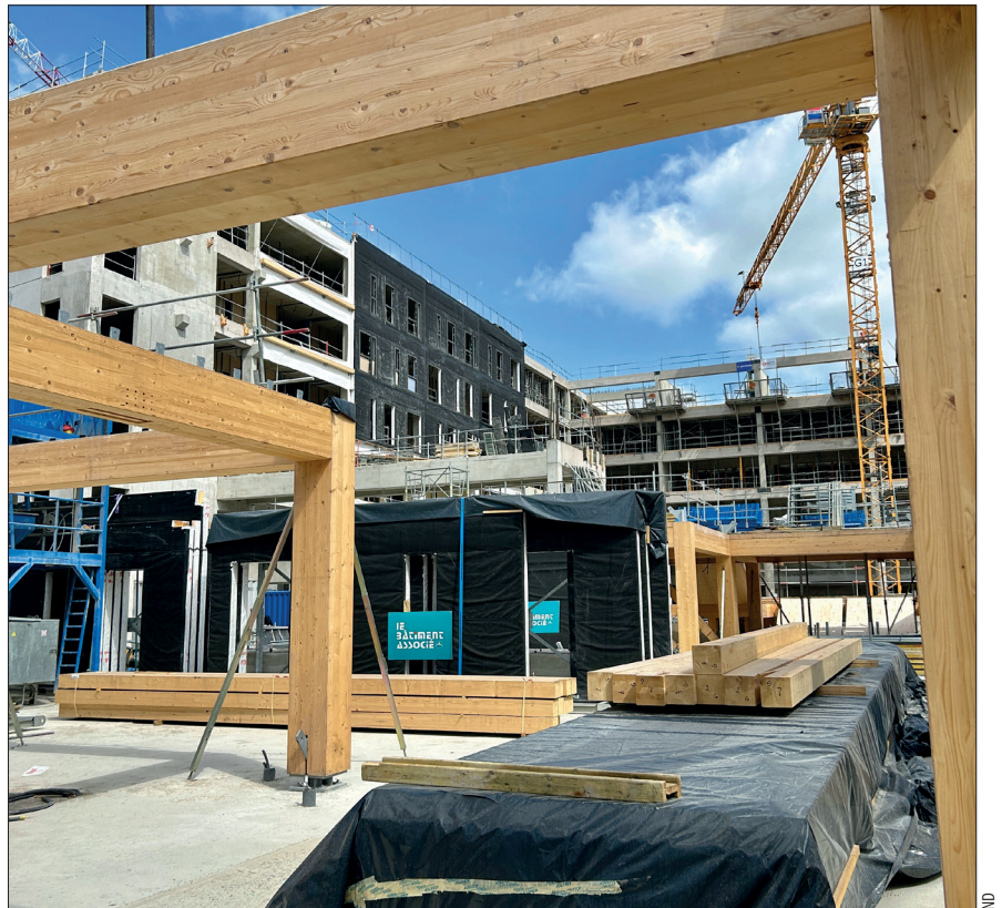
Page 3 Le Bâtiment Associé monte la charpente mais aussi les façades à ossature bois du chantier.
