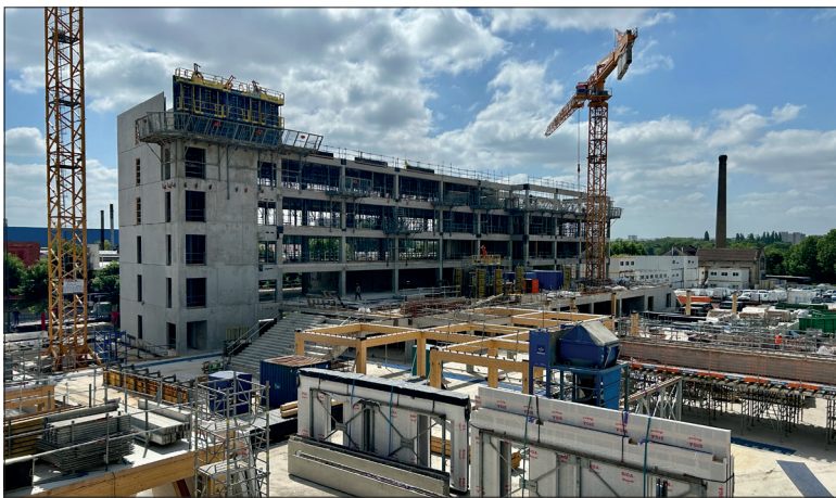
Pour ce chantier, le Bâtiment Associé utilise 950 m 3 d'épicéa apparent et 120 m 3 de douglas pour la pergola extérieure.
