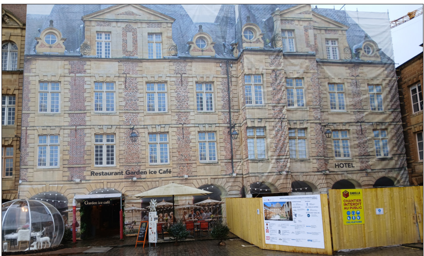
La façade donnant sur la place Ducale a été dotée d'un trompe-l'œil.
