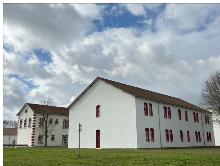
Des travaux et des actions de performance énergétique ont été effectués sur l'ensemble des 187 bâtiments du camp, soit une surface de 188 000 m 2 . Soixante bâtiments ont bénéficié de travaux d'isolation par l'extérieur, comme ici à droite.
