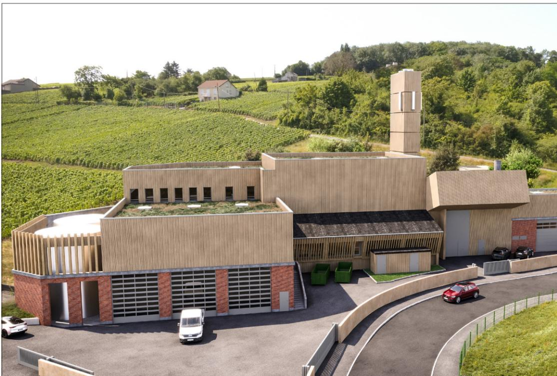
La chaufferie existante du Mont Bernon sera réhabilitée et progressivement remplacée par deux chaudières biomasse et une chaudière alimentée au biométhane.
